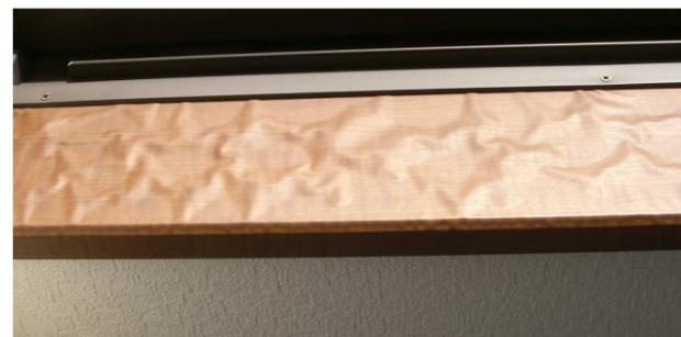
これからの季節、どうしても暖房による室内の温度と、冷たい外気温の差が発生します。その結果結露が発生します。これを解消してくれるのがペアガラス、もしくは断熱内窓（二重サッシ）です。開口部の断熱性能を高める事により、室内の空調効力も上がりますので、エネルギーの節約にもなります。
